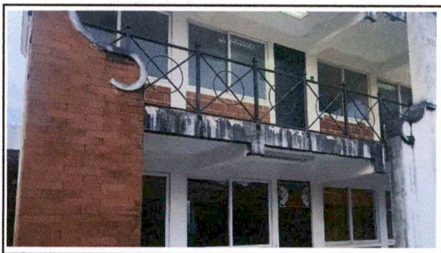
Foto 6: Modulo nuevo Aulas
