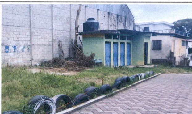
Foto 9: Modulo de baños
