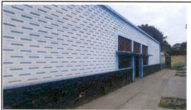
Foto 4: Fachada escuela modulo viejo aulas
